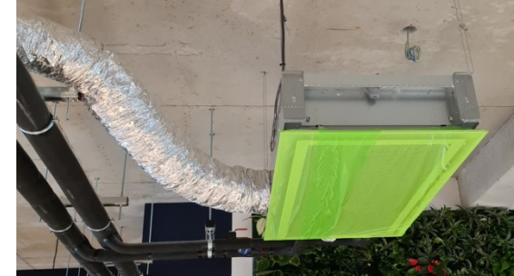
Conditionnement des poutres climatiques
