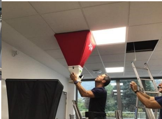
Mesure avec cône à compensation
